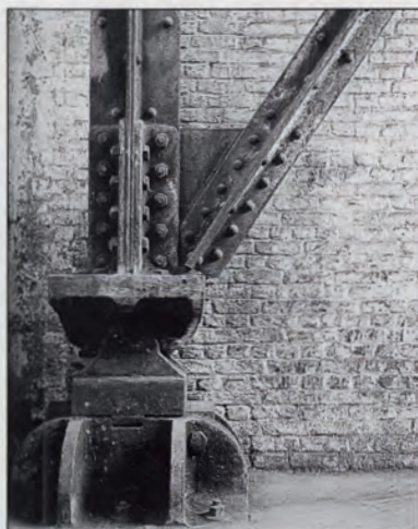
Detail van de scharnierstructuur aan de basis van één van de portieken die de bewegingen opvangen van bodem en dakgebinte. Foto Marie-Françoise Plissart
