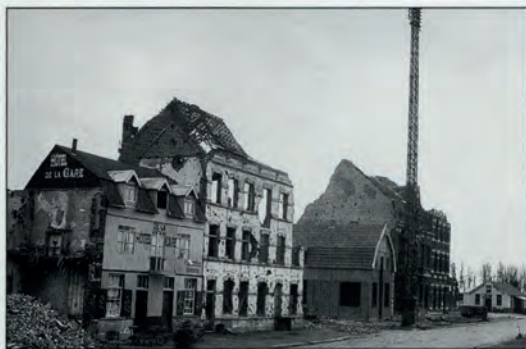
WEDEROPBOUW VAN DE HOTELS OP HET STATIONSPLEIN VAN IEPER, 1919 FOTO: IN FLANDERS FIELDS MUSEUM, IEPER
