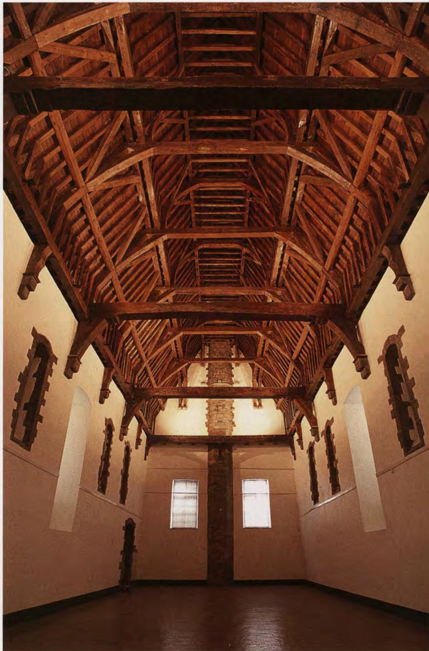
Het dakgebinte van de bovenlakenhalle
