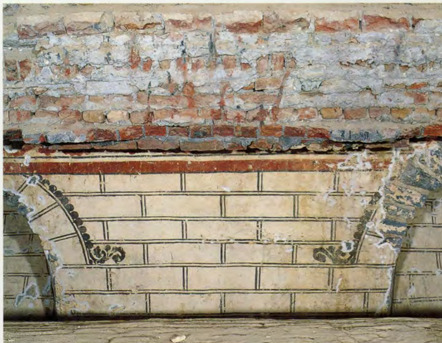
13de-eeuwse schilderingen in de kelderverdieping van de reftervleugel
