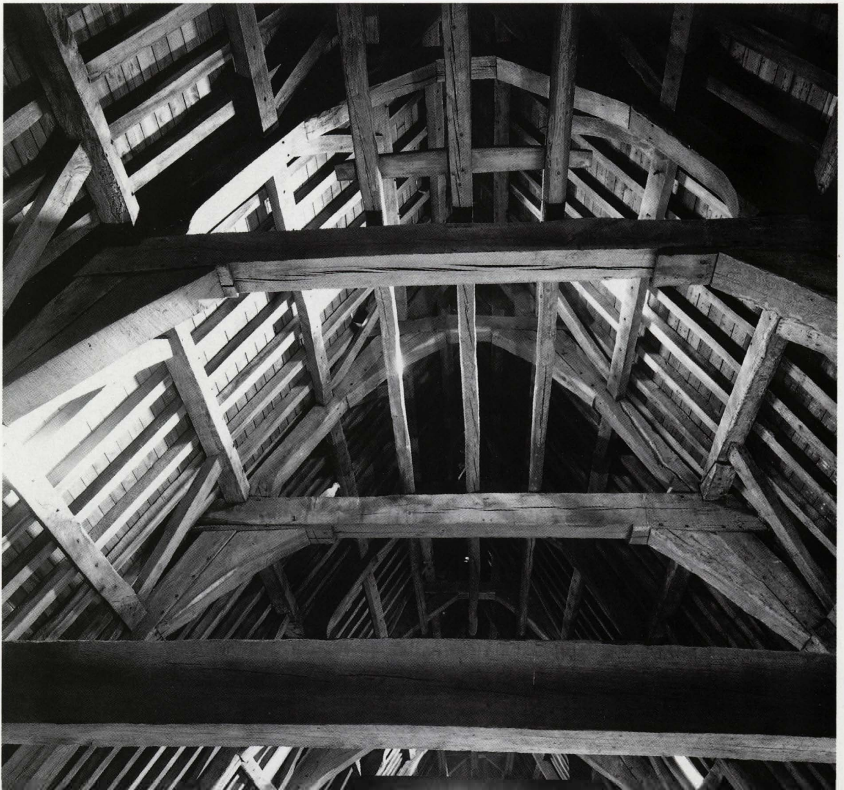
Het monumentale dakgebinte boven het gewelf van het hoogkoor (Opname 1991).
