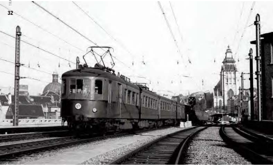
Elektrisch motorstel MR 35 op de Noord-Zuidverbinding ter hoogte van station Brussel-Kapellekerk, jaren 1950
