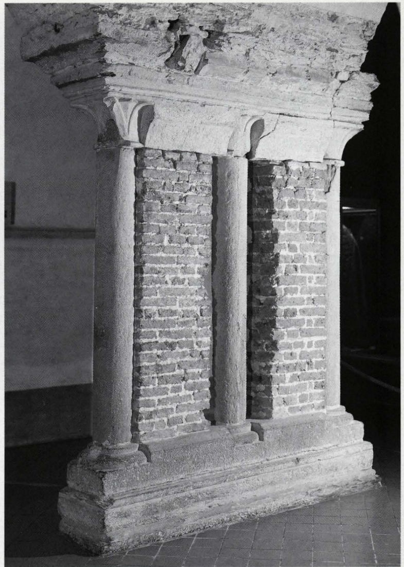
In de crypte werden de gebarsten Romaanse zuiltjes omstreeks 1235 vervangen door andere. De ruimte tussen die zuiltjes werd opgevuld met baksteen om de stabiliteit te vergroten.
