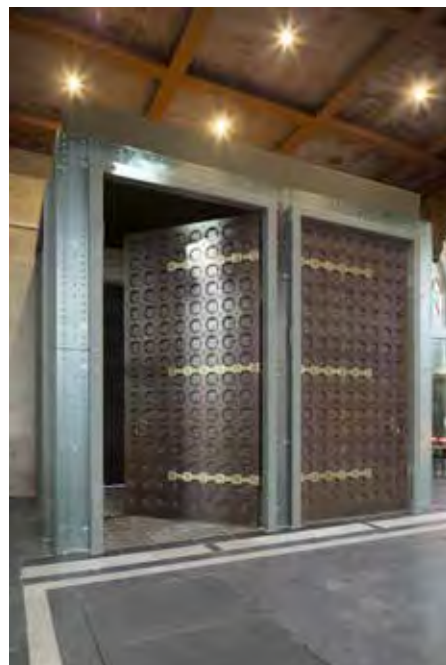
Het nieuwe tochtportaal aan de hoofdtoegang combineert de 19 de -eeuwse houten deuren met een hedendaagse creatie in glas en metaal
