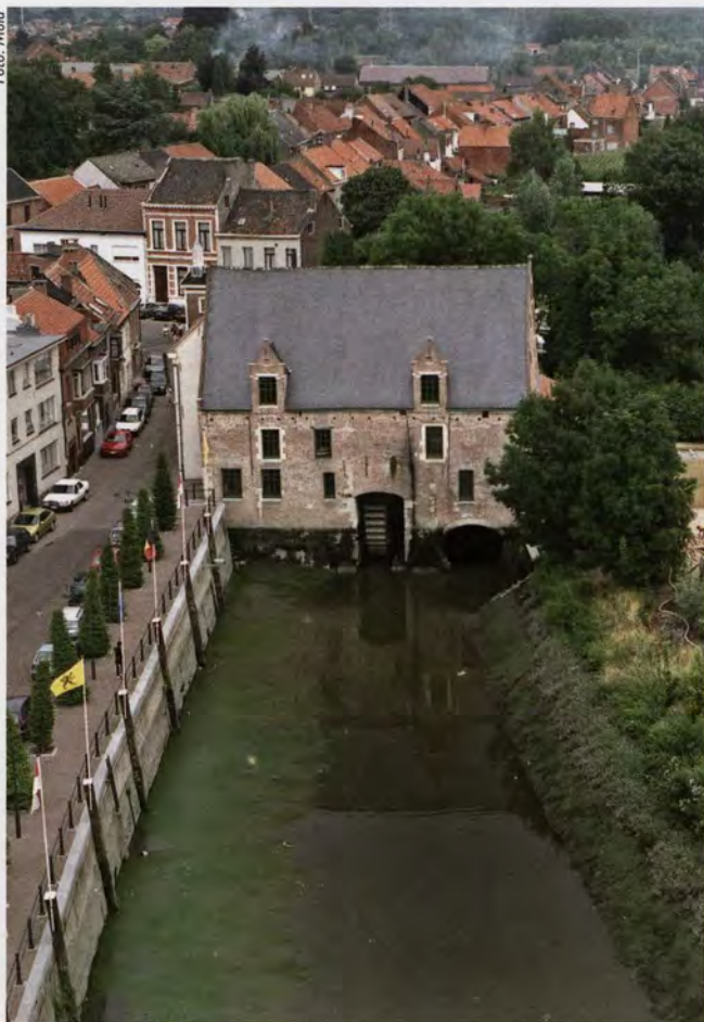
Getijdenmolen te Rupelmonde (Kruibeke) bij eb. Het inlaatgat om water bij opkomend tij in de spaarkom achter het molengebouw te laten stromen is nu zichtbaar evenals het reusachtig waterwiel met een doorsnede van 6 meter.
