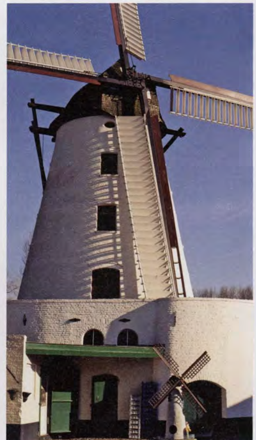
Rodenburgmolen te Marke (Kortrijk), gebouwd in 1840, is uitgrust met een haspelwiekenkruis en jalouziekleppen. Hij herbergt een graanmolen en olieslagerij.
