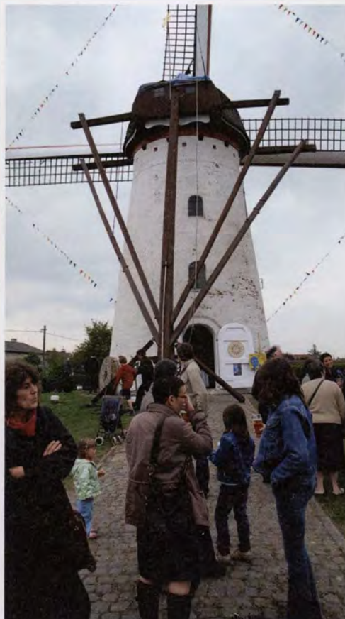
De grondzeiler Stenenmolen, in feesttooi, te Ertvelde dateert van 1798
