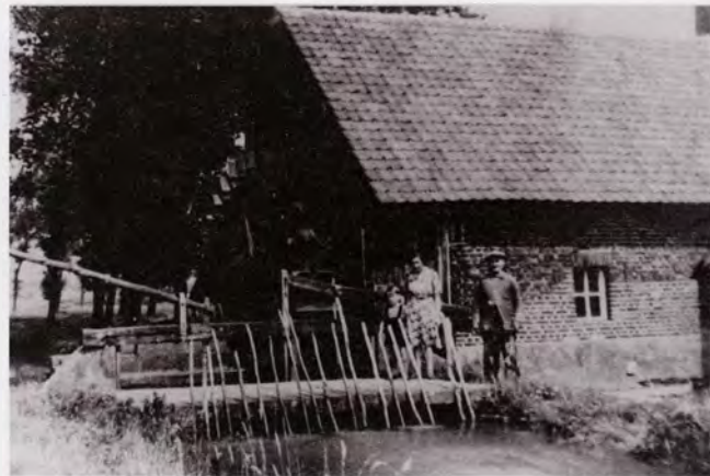
De Slagmolen van Ellikom, begin 18 de eeuw, op zijn oorspronkelijke site te Ellikom (Meeuwen-Gruitrode), in 1963 overgebracht naar het Openluchtmuseum Bokrijk te Genk.
