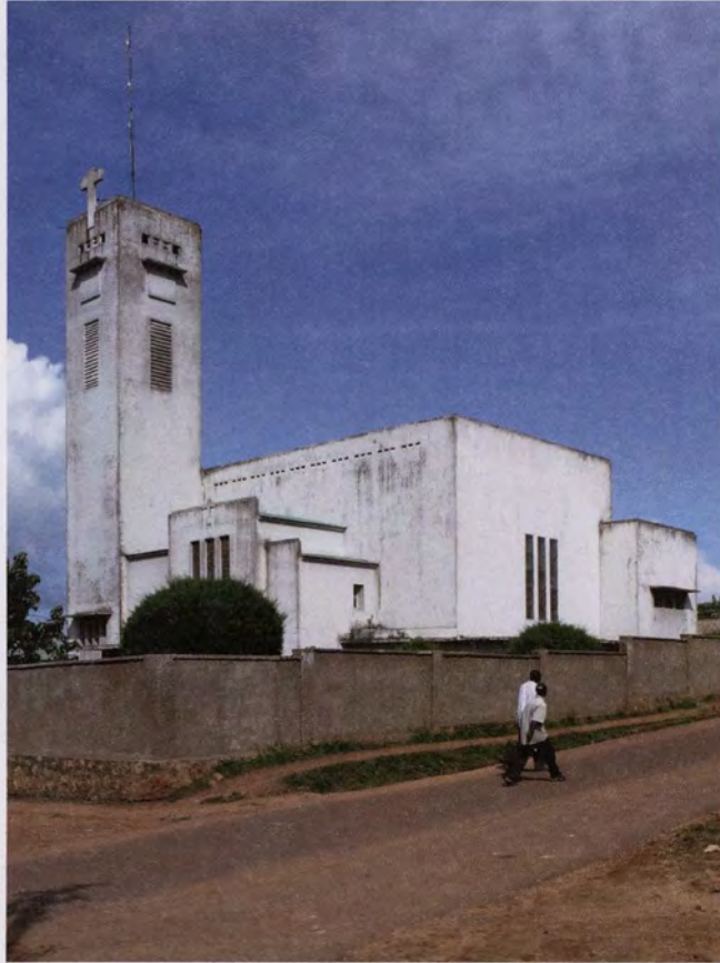
Administratief gebouw met prefab metalen structuur in Mbanza-Ngungu, laat negentiende eeuw
