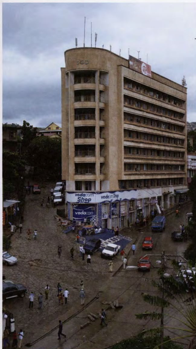
Kantoorgebouw van de Société Générale de Dragage te Matadi, architect G. Ricquier, jaren 1950
