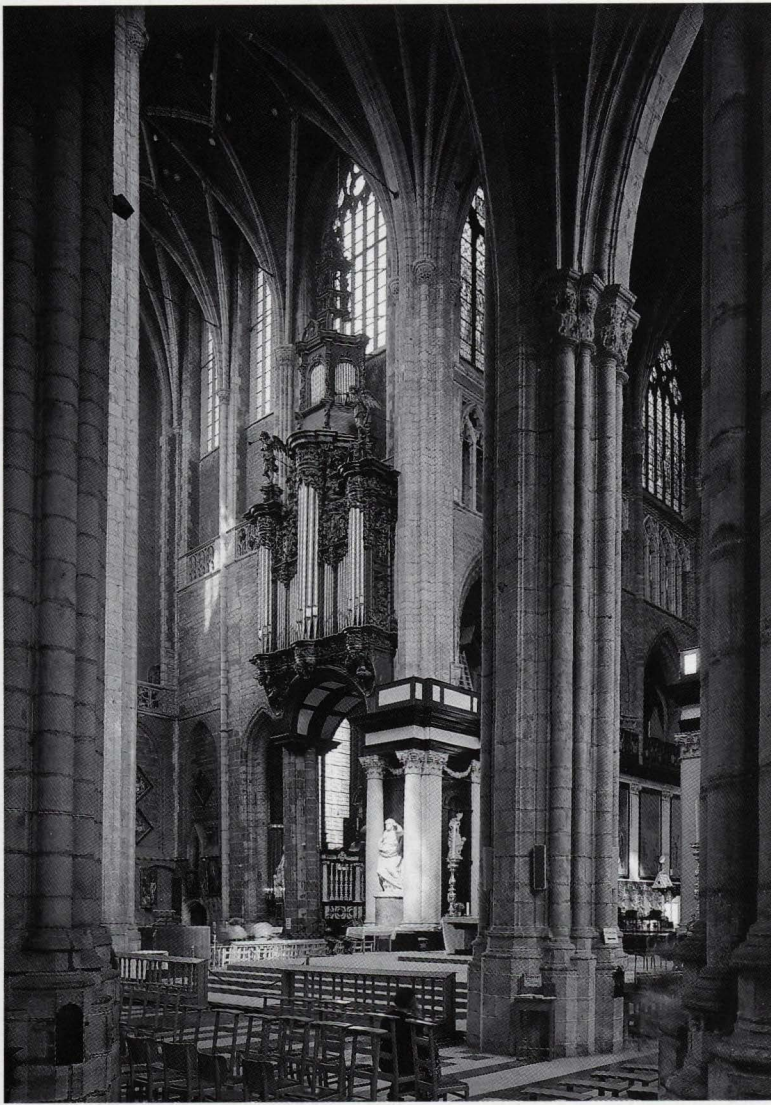
Tussen het lang uitgestrekte koor, salon van het toenmalige Gentse kapittel, en het middenschip, is nu het nieuwe liturgische centrum ingeplant, dat aan de zijkant wordt beheerst door het monumentale orgel.
