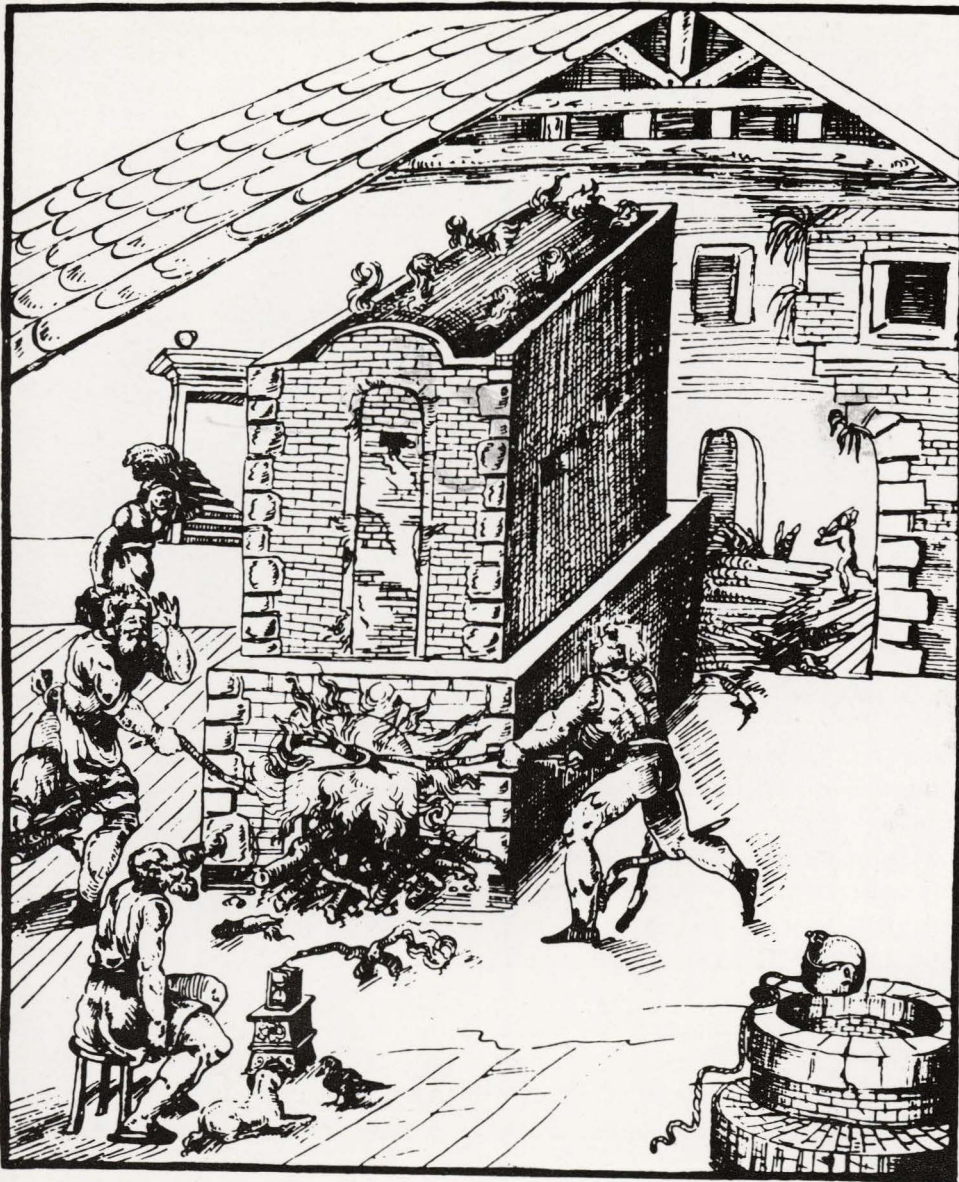
13. Piccolpasso: tekening van een pottenbakkersoven. De meester-pottenbakker controleert de hitte van de oven door middel van een zandloper.
