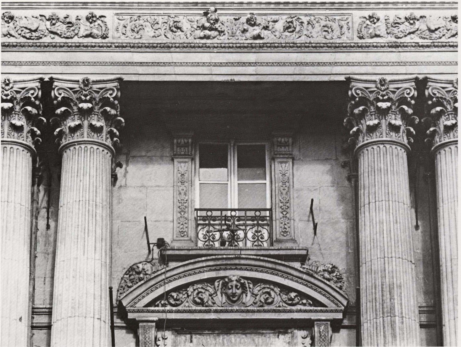
E. Carpentier (1819-1886). Hotel Continental, De Brouckèreplein 41, Brussel (detail). 1874.
